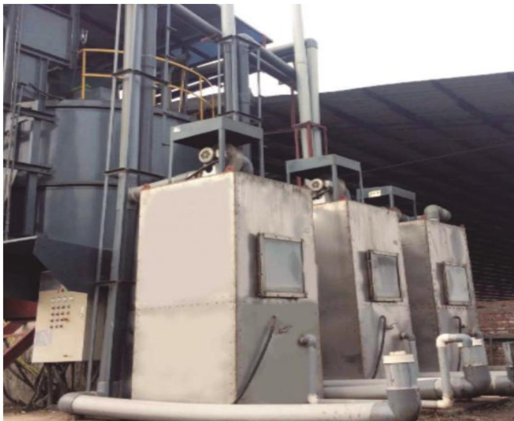
图 6.2.1.2 堆肥机自带除臭装置实体图
